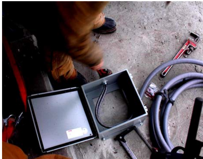
Figure 3.5 NEMA 12 enclosure (UDOT)
