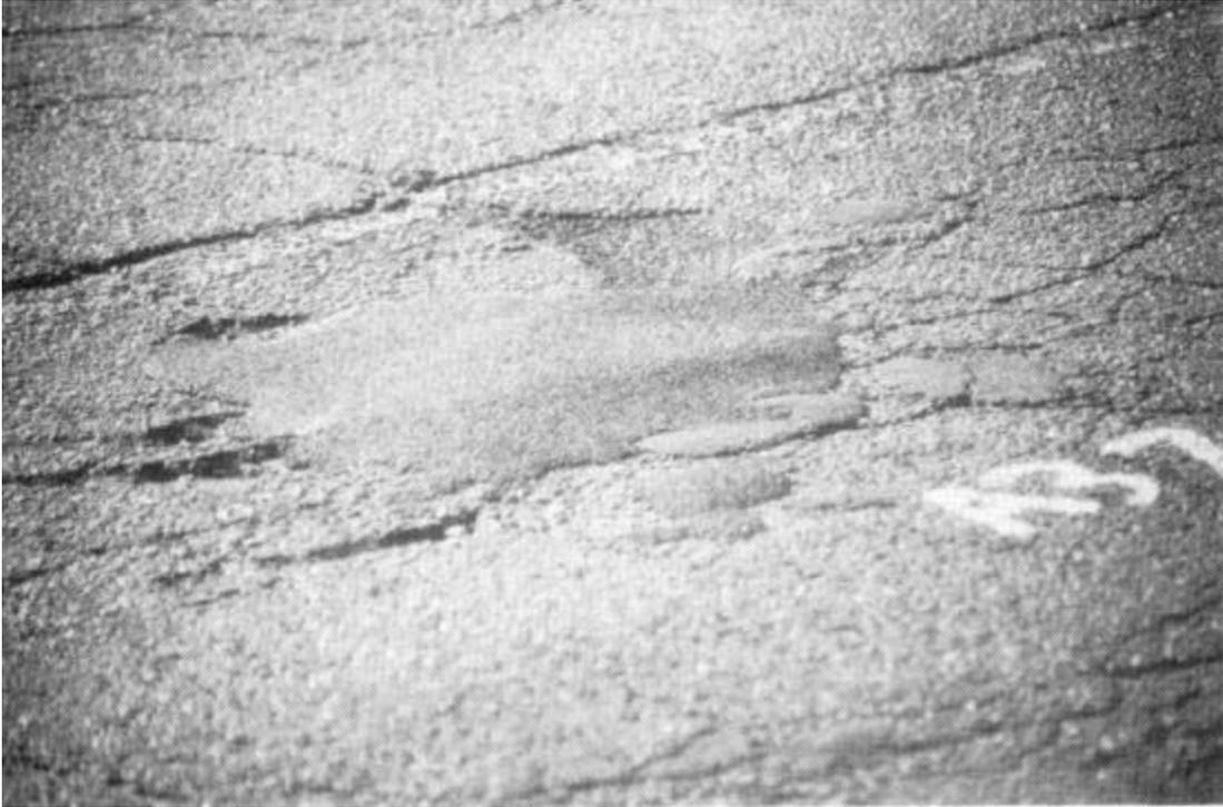
**Figure 3. Edge Disintegration Distress** <sup>(3)</sup>
