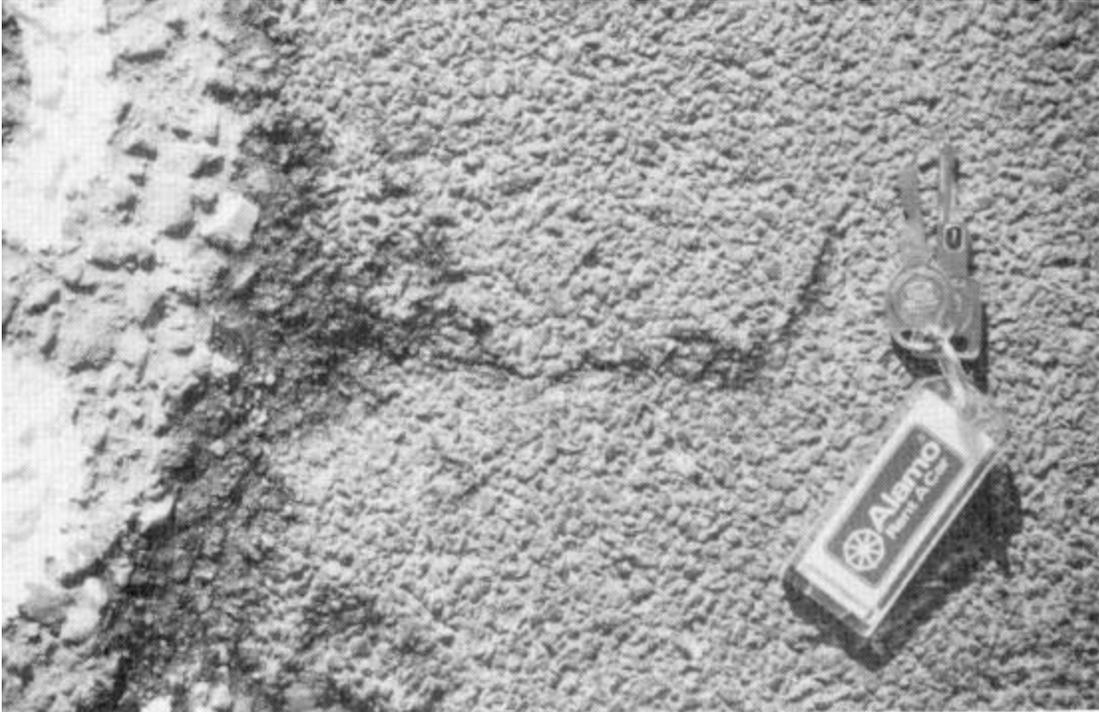
**Figure 2. Cracking Distress** <sup>(3)</sup>
